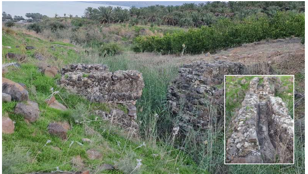
שרידי גשר אמת המים הקדומה לטבריה בחצייתה את אפיק נחל שלם והתעלה הבנויה והמטויחת. (צילום ח' ממליה)
