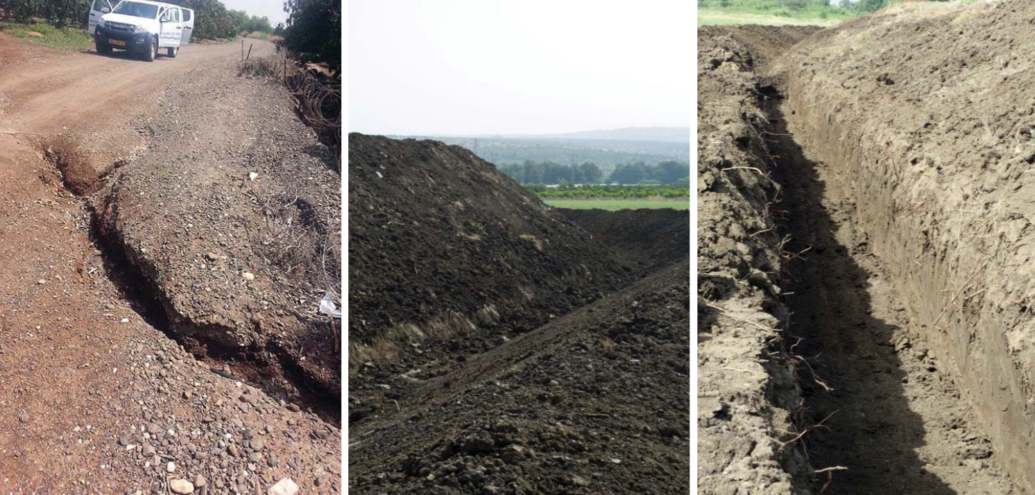
מימין ובאמצע: עבודות ניקוז שטחים, משמאל: בעיות של סחף קרקע צילומים: גיא קולר
