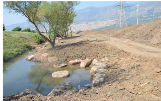
מיתון הגדה המזרחית. העברת חומר ליצירת סוללה עליה יישתלו עצים ליצירת חיץ למסדרון הנחל. בית גידול של זרימה איטית
