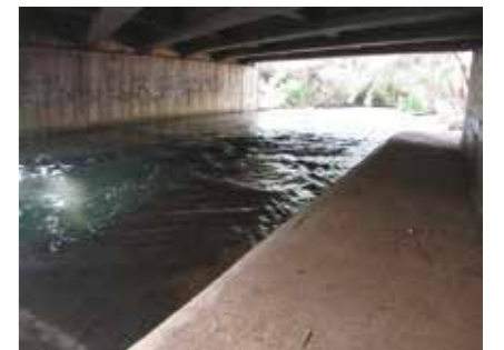
דרגש הבטון שנבנה בנחל הבניאס, מתחת לכביש 977, ומשמש גם חלק משביל האופניים בעמק
