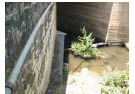
הדרגש מתחבר לקרקע היבשה מחוץ ל"קופסת" הניקוז, בשיפוע מתון. ערוץ זרימה עונתית
