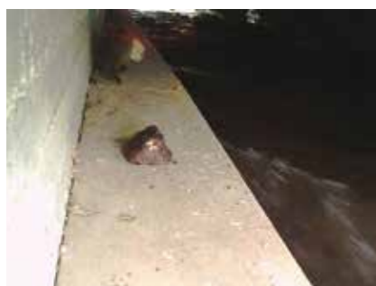
דרגש פח הבנוי מתחת הכביש במעבר ניקוז נמוך, מתחת לכביש 918 (נמייה עוברת)
