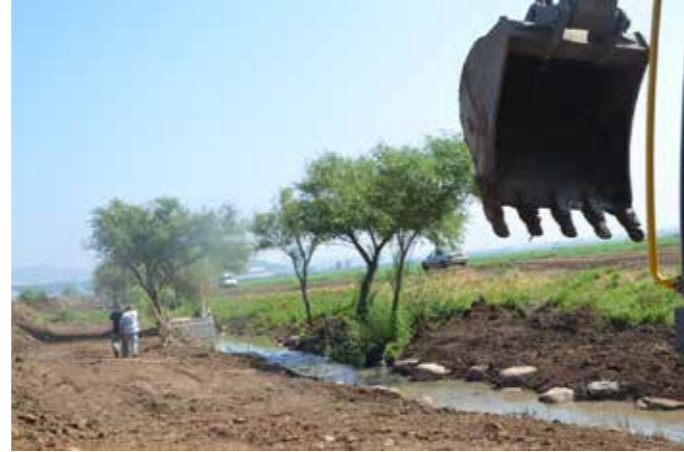
מיתון גדה ופיזור בולדרים בגדות (יצירת מורכבות מבנית). יצירת שיפועי גדות משתנים
